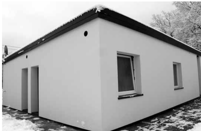
Termomodernizacja budynku LKS Śląsk Koszęcin.
