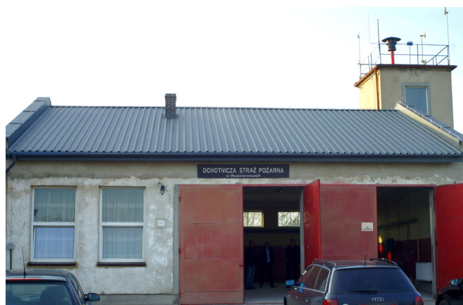
Budynek OSP w Rusinowicach zyskał nowy dach.
