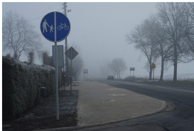
Ścieżka pieszo-rowerowa przy ul. Lublinieckiej już gotowa do użytku.
